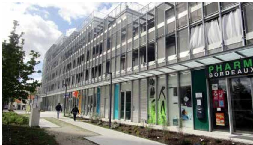
Counord : une entrée de quartier entièrement restaurée pour le Grand Parc.
