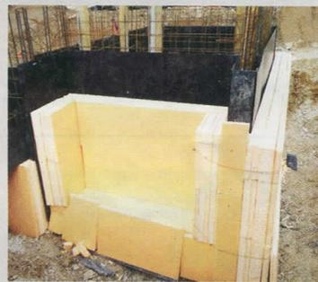
**2** La jonction entre vide sanitaire et façade est une source importante de ponts thermiques. Le fibrastyène de 25 cm en sous-face de plancher est prolongé en retombée et l'isolation par l'extérieur de la façade est réalisée jusqu'aux fondations.
